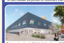
Future extension de l'hôpital attendue en 2023.
