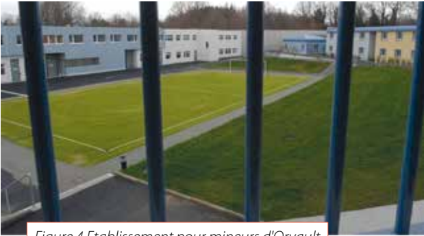
Figure 4 Etablissement pour mineurs d'Orvault
