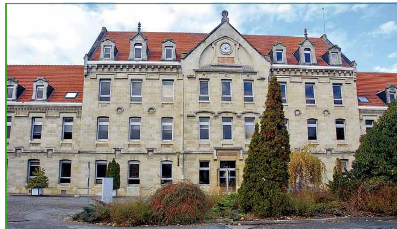
Bâtiment administratif du C.H. Charles Perrens, CHU Bordeaux
